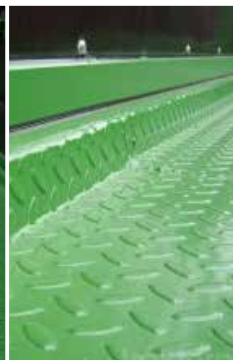
T046/1 - bordázott acél padlólemez a csúszás megelőzése érdekében
